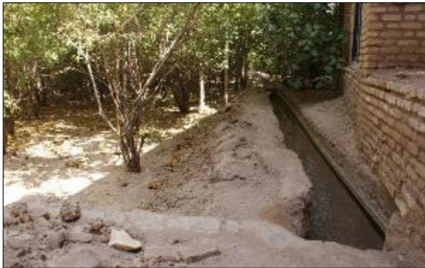
تصویر ۴. وارد شدن قنات بلافاصله از مظهر به باغ حاج سیدمحمدعلی (عکس از: نویسندگان مرداد ۱۳۹۵).
